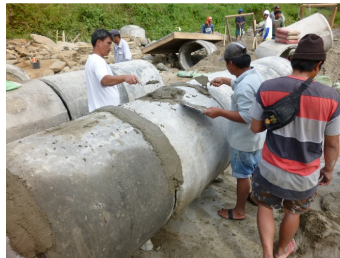
接続部をモルタルで補強
