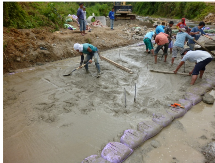
基礎天端を計画高で平坦に仕上
