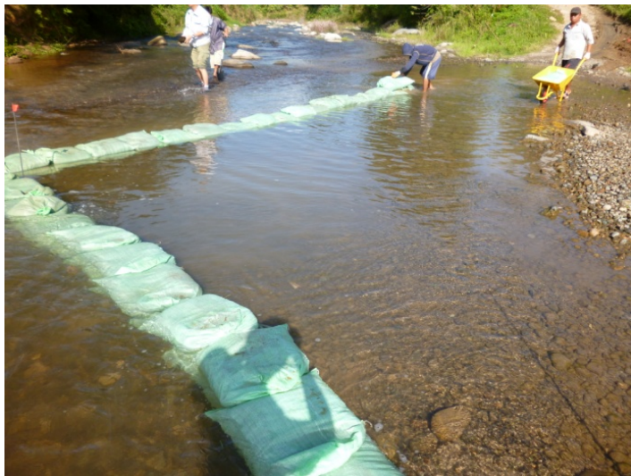
工事区画の水位を下げるため締切
