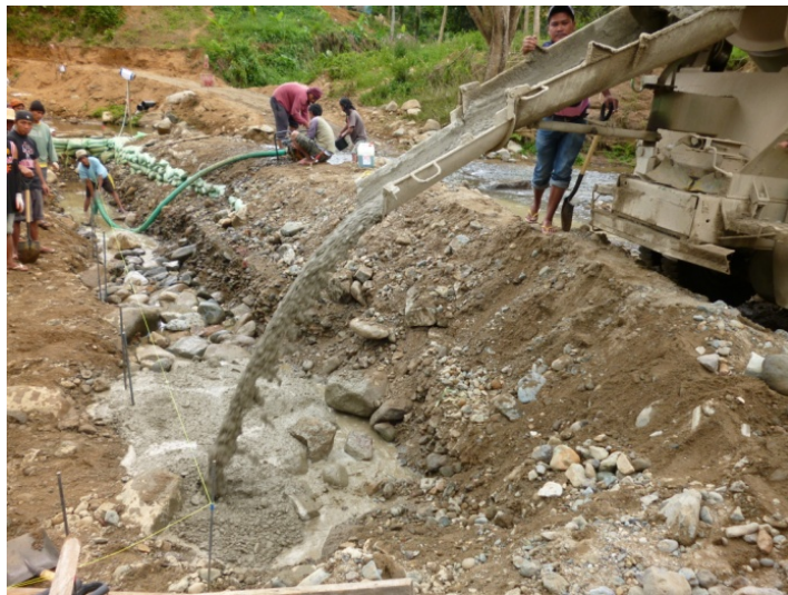
水中ポンプで排水し玉石を投入，コンクリート打設
