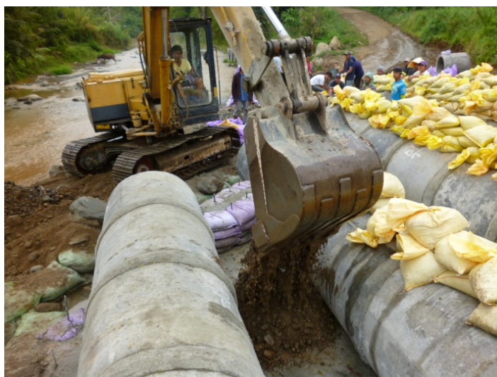
カルバート下半部は川砂利を利用
