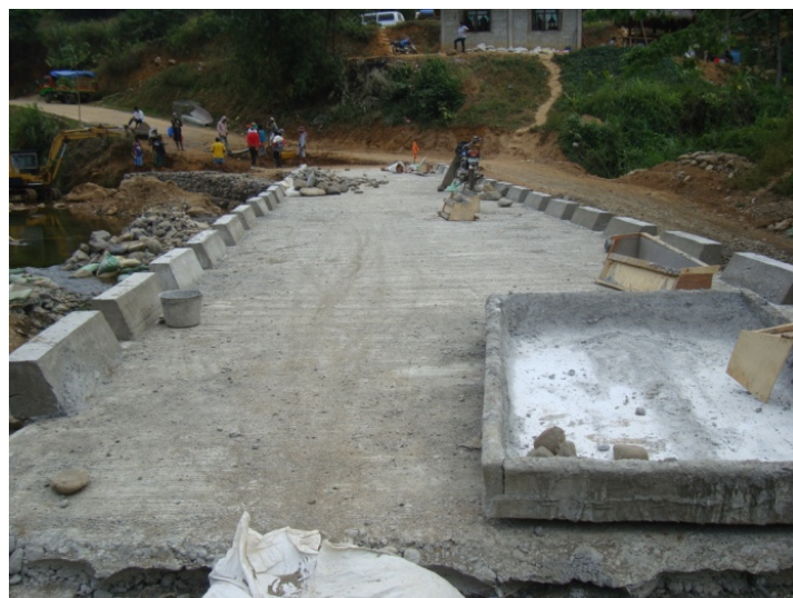
舗装コンクリート打設後
