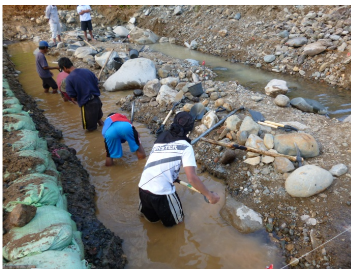
水中ポンプで排水，人力による床付
