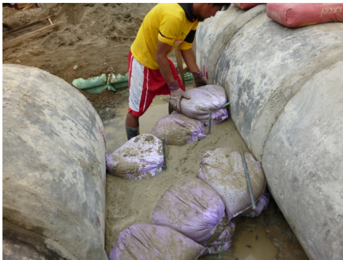
土のうの敷設
