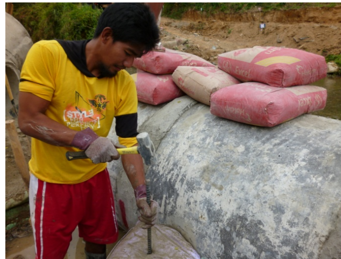
土のう中詰固化前に鉄筋を挿入，各層を一体化
