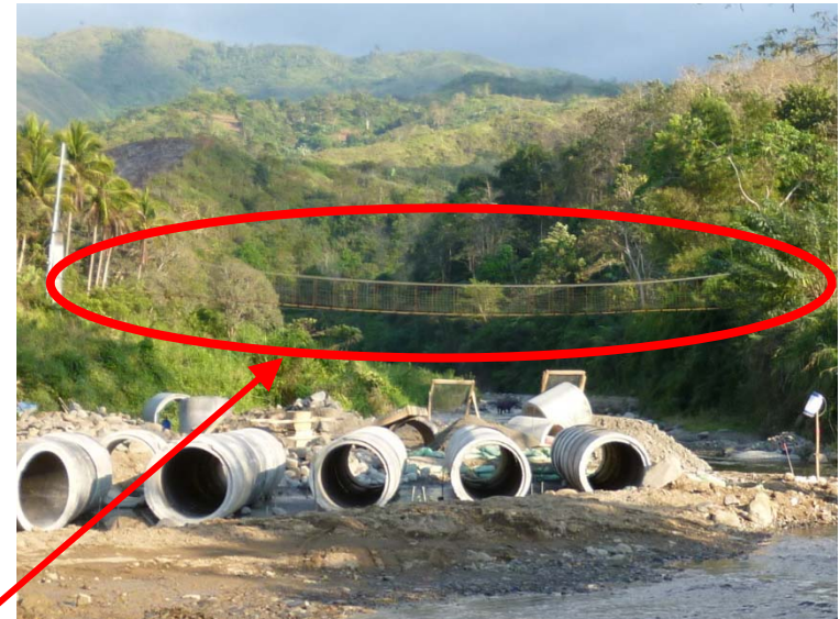
施工地点近くにあるつり橋
