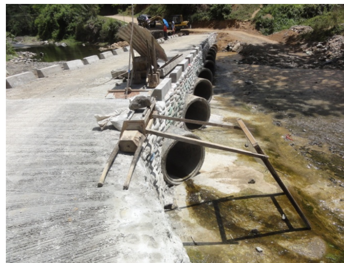
路肩表示を設置
