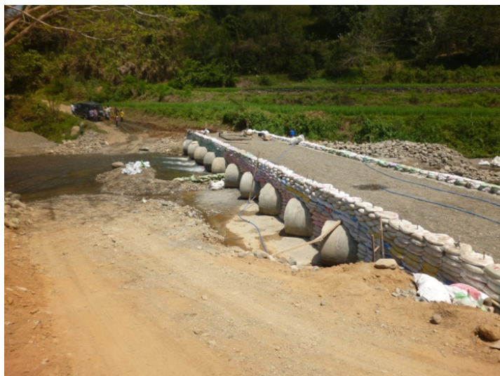
路盤材を敷きだし、含水比調整
