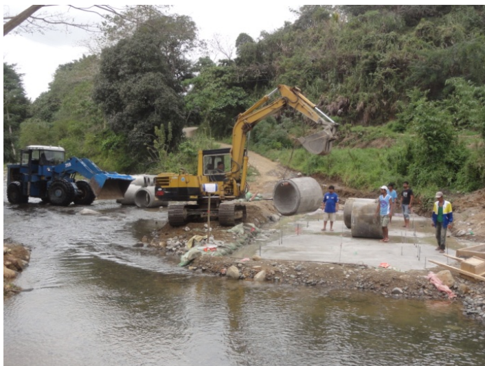
カルバート管を移動，設置
