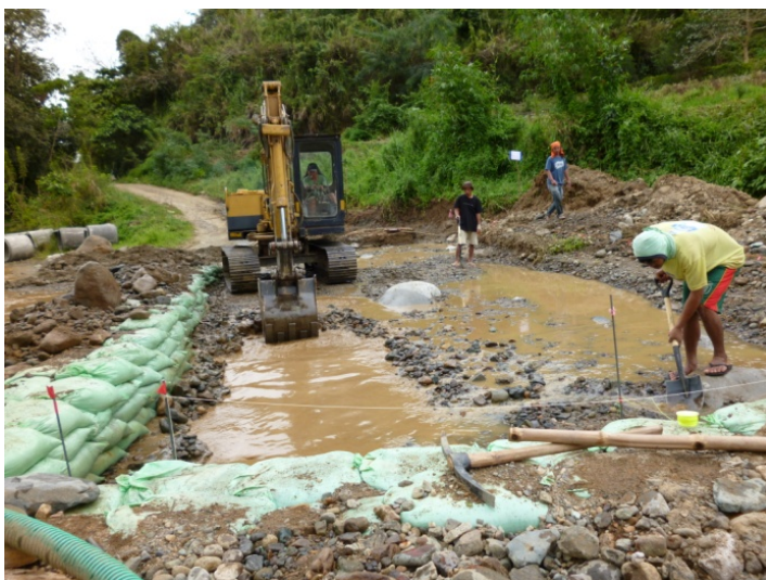
バックホウ（町所有）にて基礎・止水壁部の掘削
